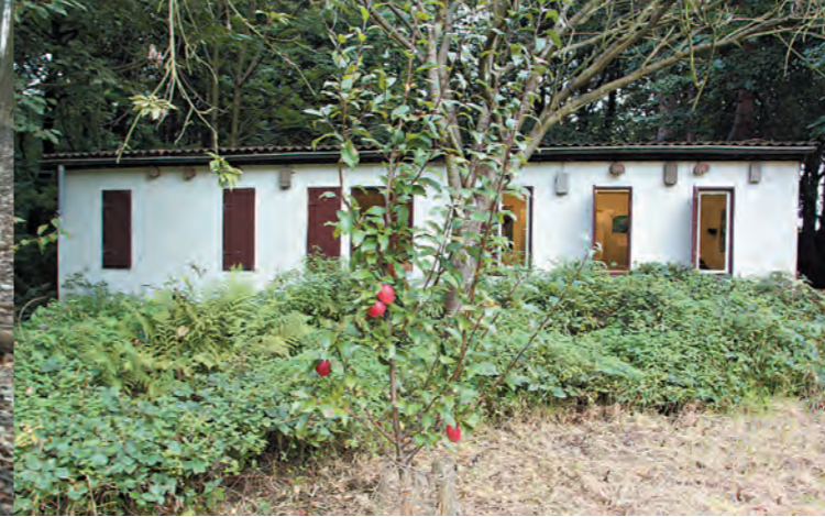
Das NABU-Haus im Höntroper Südpark.
